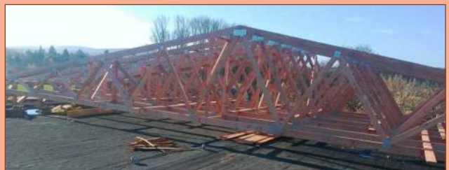
Konštrukcia novej strechy telocvične na Farskej lúke
