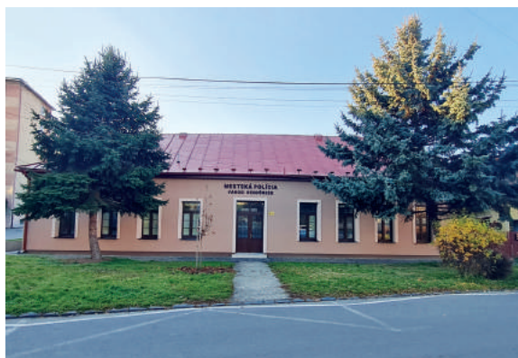
V roku 2021 sa dokončili aj stavebné práce v areáli bývalej ZUŠ, kde už o nedlho vznikne denný stacionár pre seniorov. V rámci prác mesto obnovilo aj časť, v ktorej dnes sídli mestská polícia.
