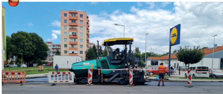
Ako každý rok, ani v roku 2021 nechýbalo asfaltovanie ulíc. Nový asfalt dostali ulice 1. mája, Kukučínova, Moczáryho, križovatka pri Lidli či cesta a chodníky na cintoríne.
