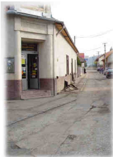
Pred obnovou, rok 2006
