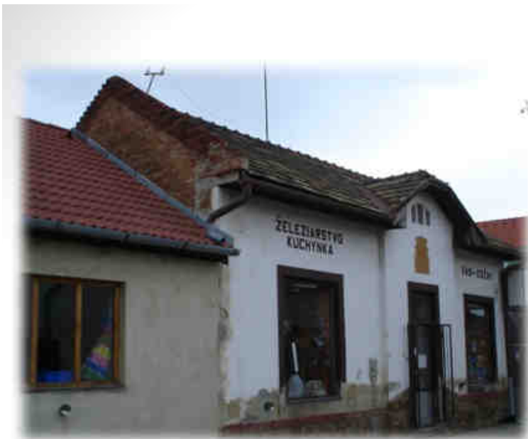
Pred obnovou, rok 2006
