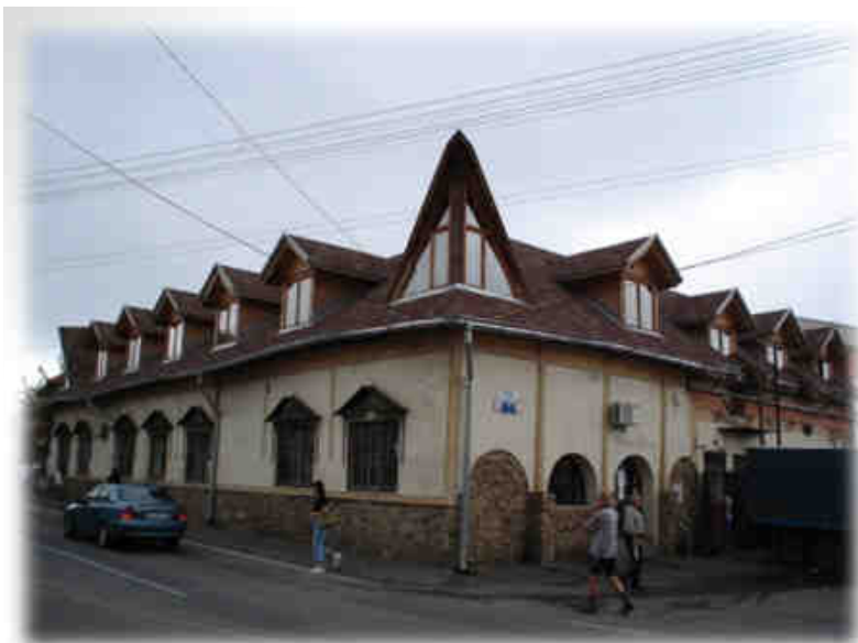
Pred obnovou, rok 2006
